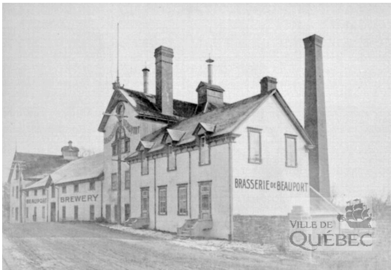
Les bâtiments de la Brasserie de Beauport avant leur démolition. AVQ; Fonds Michel Bédard.
